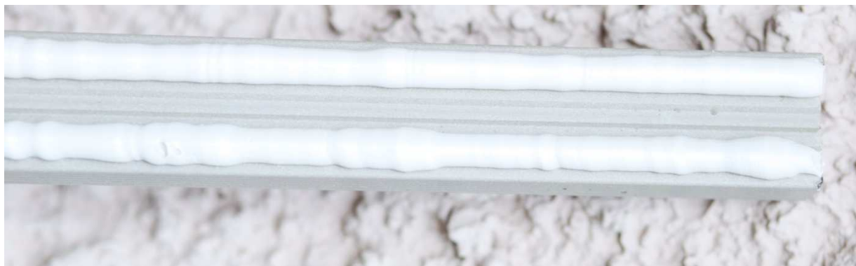
Zdj. 4 - nakładanie kleju HERQLES V2
