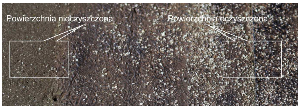
Zdj. 2 - widoczna różnica między podłożem oczyszczonym a nieczyszczonym
