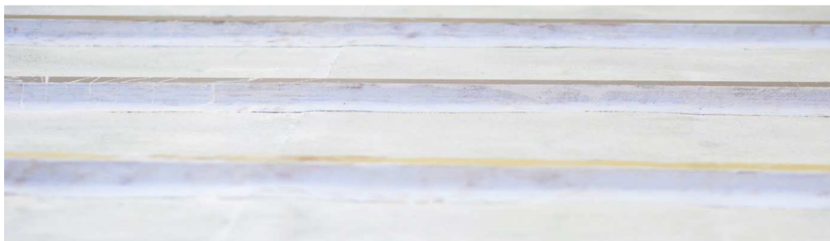
Zdj. 9 - wklejona włóknina i 1-wsza warstwa hydroizolacji HERQLES DSP
