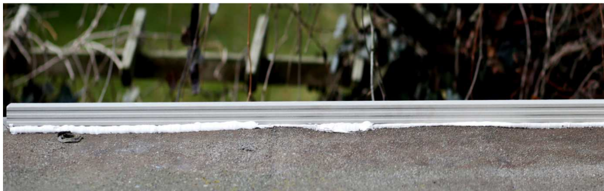
Zdj. 5 - korygowanie nierówności i ustawienie spadku podłużnego na spoinie kleju
