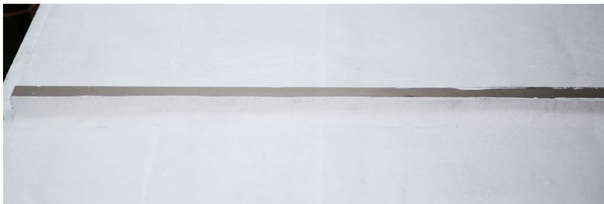
Zdj.10 - membrana wykonana z 2-ech warstw hydroizolacji HERQLES DSP
